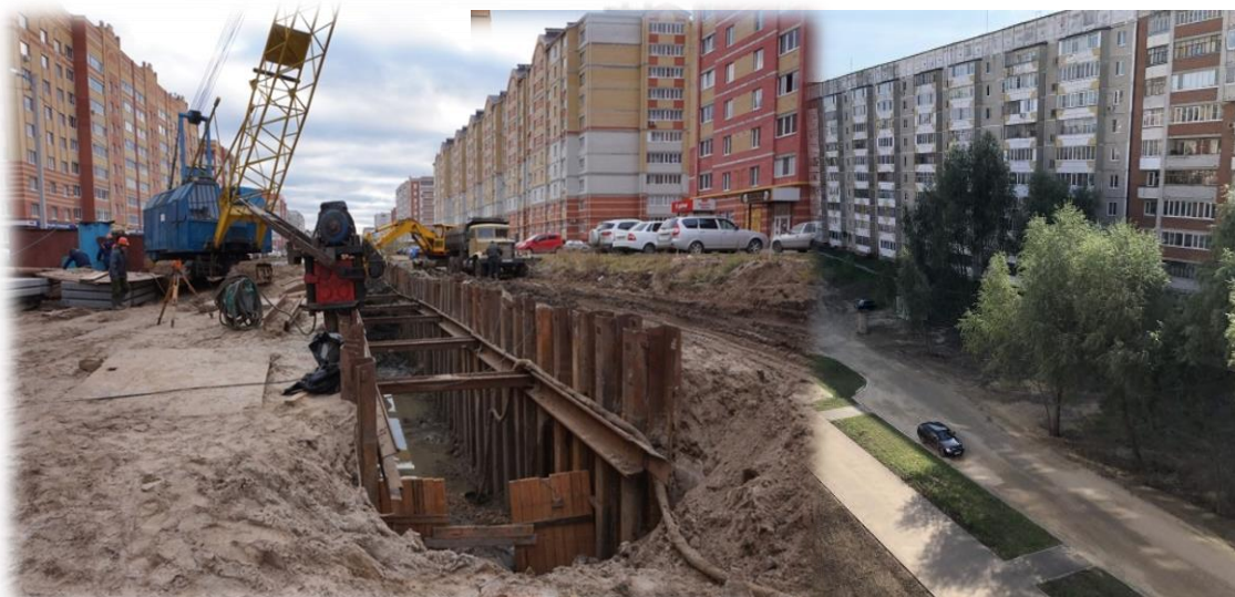
Строительство дорог по ул. Петрова и бул. Ураева
