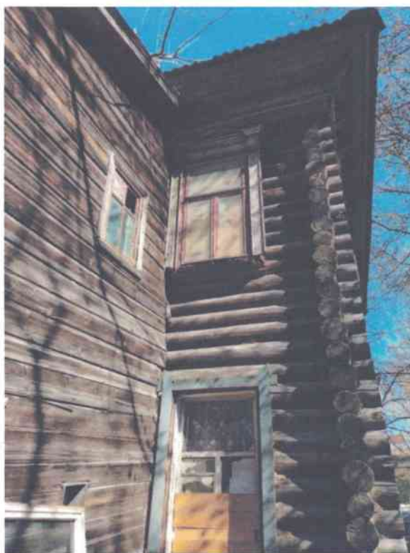
Фото 12. ОКН «Дом с деревянной резьбой». Фрагменты юго-западного фасада. Следы увлажнения и загнивание древесины в чашках соединения бревен, поражение древесины жучком; архитектурный декор имеет сколы, утраты, на локальных участках древесина нижней части наличников поражена гнилью, ослаблены крепления декоративных элементов; оконные переплеты, коробки и подоконные доски частично поражены гнилью и жучком, частично отсутствуют штапики, трещины стекол, остекление частично отсутствует.
