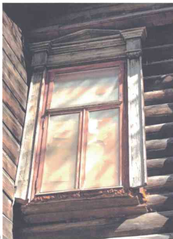
Фото 12. ОКН «Дом с деревянной резьбой». Фрагменты юго-западного фасада. Следы увлажнения и загнивание древесины в чашках соединения бревен, поражение древесины жучком; архитектурный декор имеет сколы, утраты, на локальных участках древесина нижней части наличников поражена гнилью, ослаблены крепления декоративных элементов; оконные переплеты, коробки и подоконные доски частично поражены гнилью и жучком, частично отсутствуют штапики, трещины стекол, остекление частично отсутствует.
